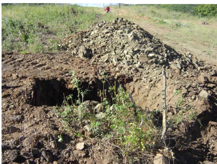
FIGURA 4 - O MATERIAL ACUMULADO JUNTO AO CORTE EXPÕE O TIPO DE TERRENO CORTADO. OBSERVE-SE QUE PRATICAMENTE SE TEM PEDRAS FRAGMENTADAS.
